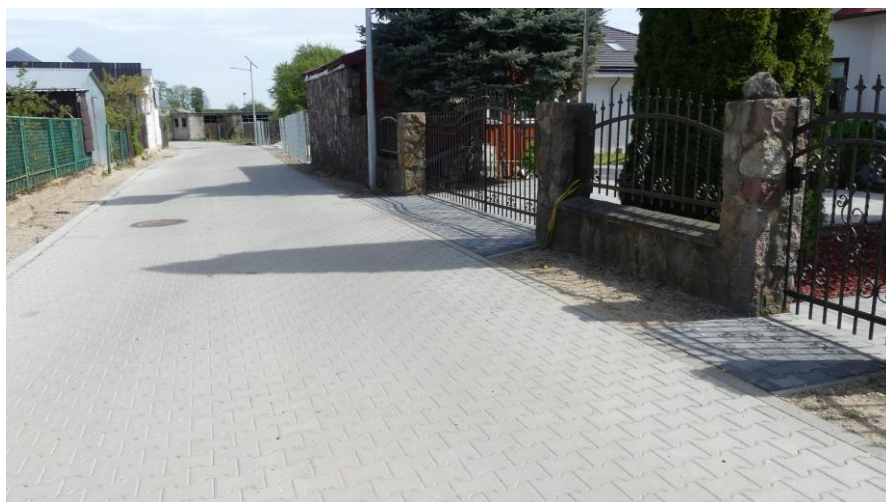
Inwestycja obejmowała wykonanie nowej nawierzchni z betonowej kostki brukowej, chodników oraz pobocza z kruszywa łamanego. W celu odwodnienia terenu zaprojektowana została kanalizacja deszczowa. Ulica została doświetlona lampami solarnymi.
