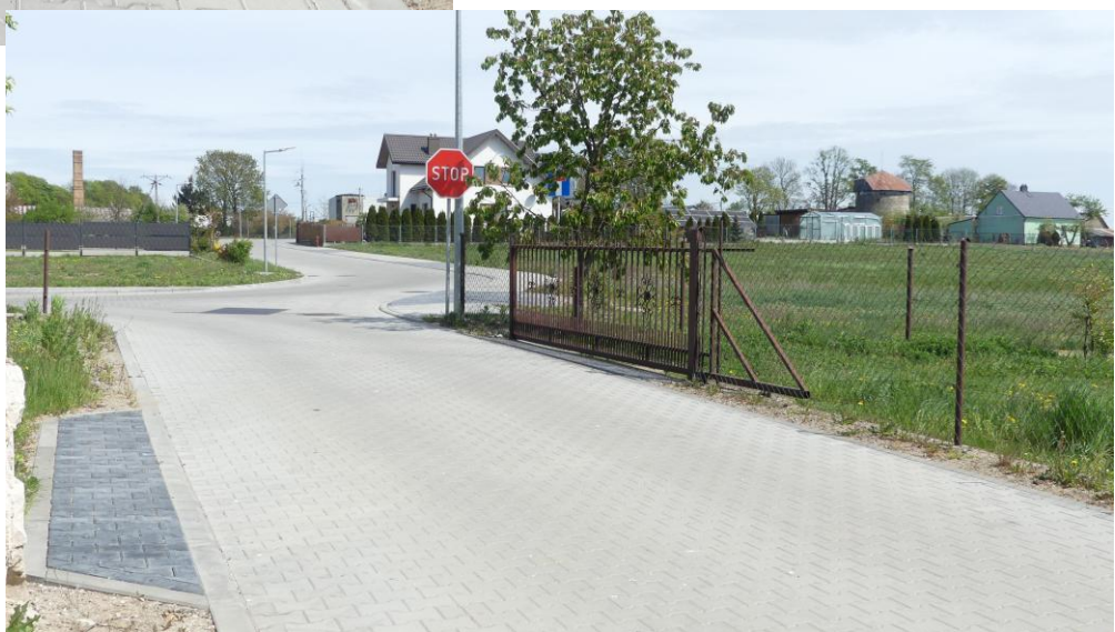
Inwestycja obejmowała wykonanie nowej nawierzchni z betonowej kostki brukowej, chodników oraz pobocza z kruszywa łamanego. W celu odwodnienia terenu zaprojektowana została kanalizacja deszczowa. Ulica została doświetlona lampami solarnymi.
